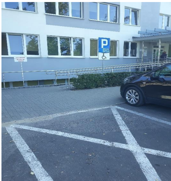
Zdjęcie nr 3. Podjazd dla osób poruszających się na wózku inwalidzkim
