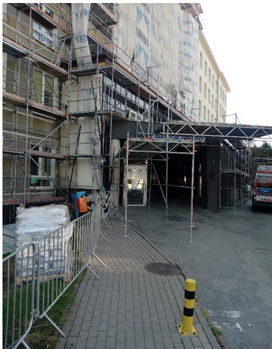
Zdjęcie nr 1. Remontowane wejście do budynku
