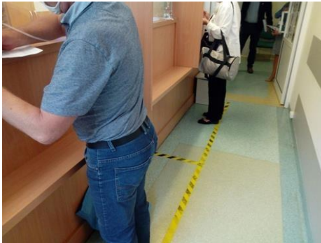
Zdjęcie nr 9. Brak obniżenia lady w rejestracji
