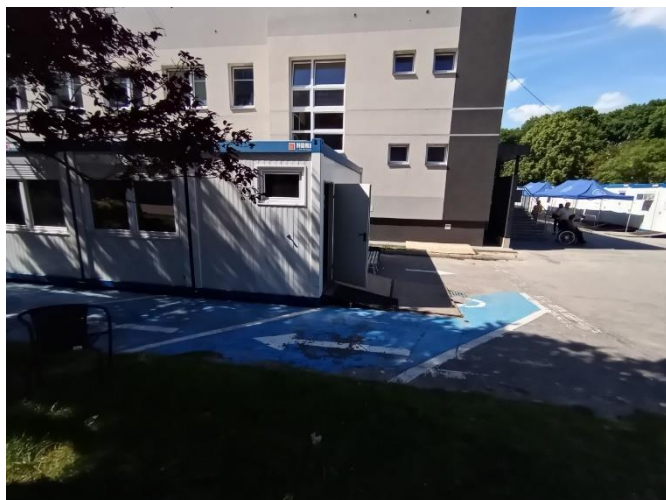
Zdjęcie nr 9: Miejsce parkingowe dla niepełnosprawnych zajęte przez tymczasowy budynek remontowy
